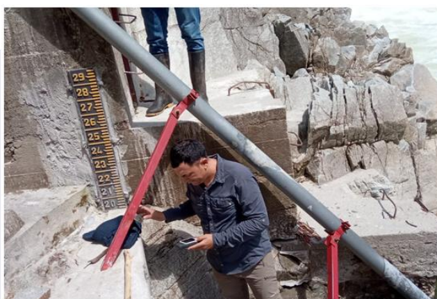
Inspección técnica AUA Hidroelectrico en la Sofía
